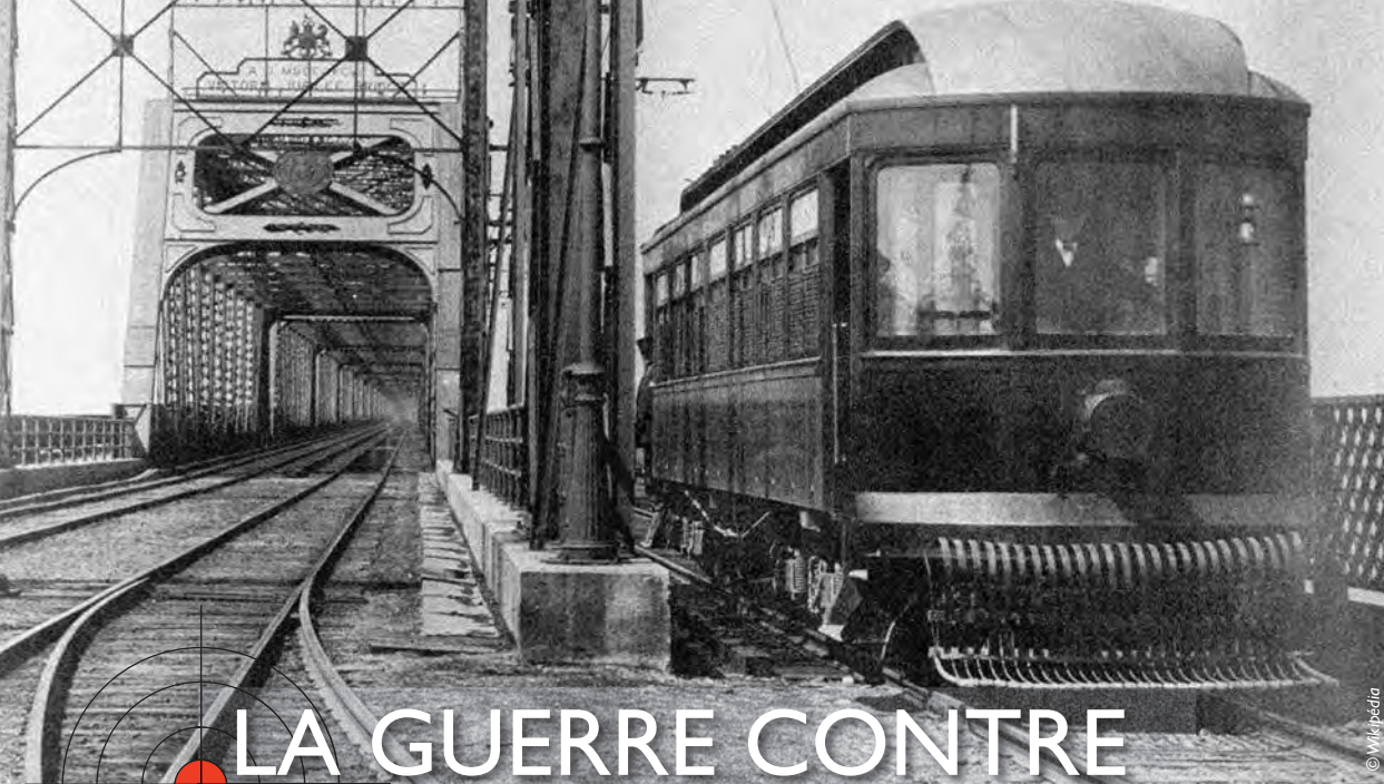
Le pont Victoria. À l'origine, la voie extérieure était réservée au tramway
